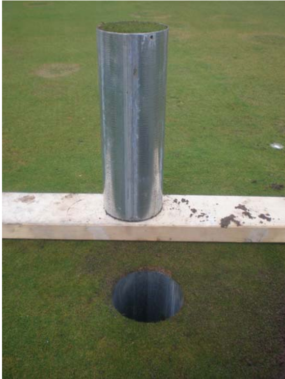
Bilde 1. Aktuell fordamping fra ulike grasarter vil bli bestemt ved daglig veiing av minilysimetre som er installert i greenen. Bildet er tatt ved montering av minilysimetrene 22.oktober 2008. Foto: Trygve S. Aamlid
