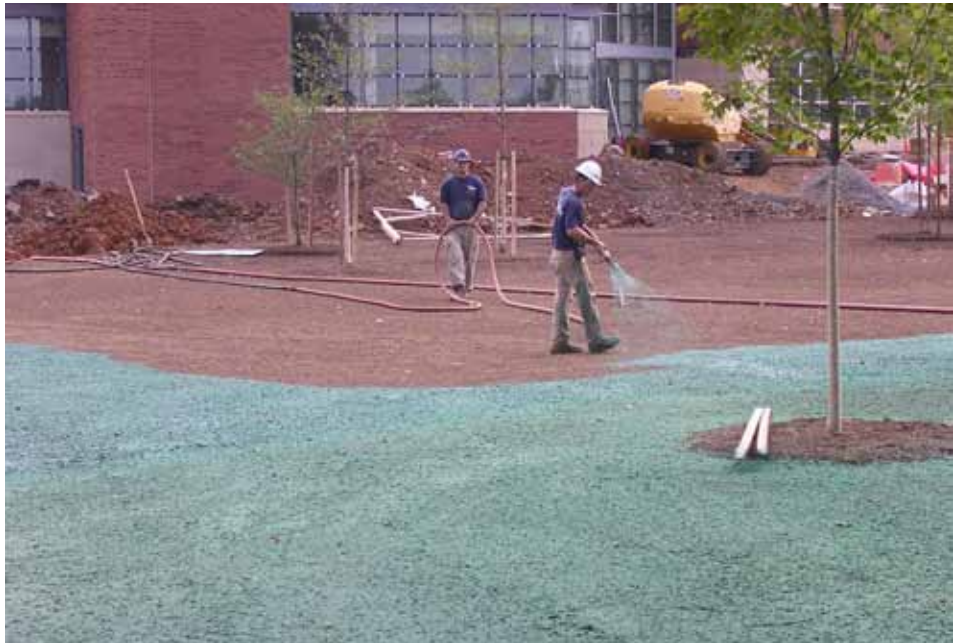
Sprutsådd med mulch där man tillsatt färgpigment för bästa täckning. Foto: Trygve S. Aamlid
