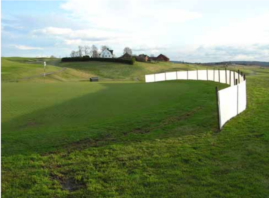
Tillfälliga skärmar för att leda ytvatten utanför greenen. Foto: Agnar Kvalbein
