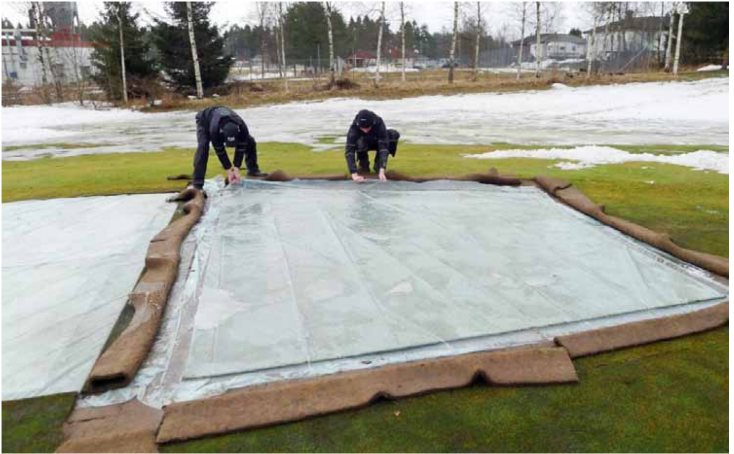
Foto 1. På Miklagard GK var de noga med att fästa den täta duken, så att det inte kom in vatten under den. Bild från våren, men det visar tydligt hur plastkanten läggs ner i jorden under gräset, som skurits med torvskäraren.
