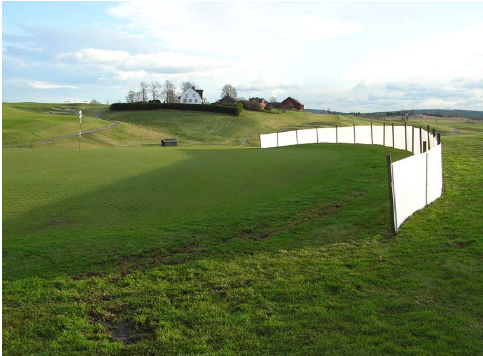
Midlertidig afskærmning for at lede overfladevand udenom greenen. Foto: Agnar Kvalbein
