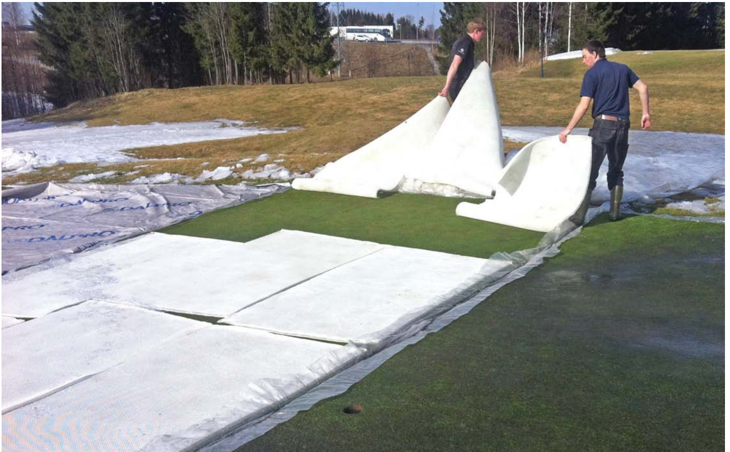
En speciell textil användes för att skapa luftlager (18 mm) mellan plast och greenyta. Här blir den borttagen från ett demonstrationsprojekt på Miklagard golfbana i Norge. Till vänster ser du en semi-permeabel duk. Till höger låg det bara en plast. Foto: Stefan Schön.
