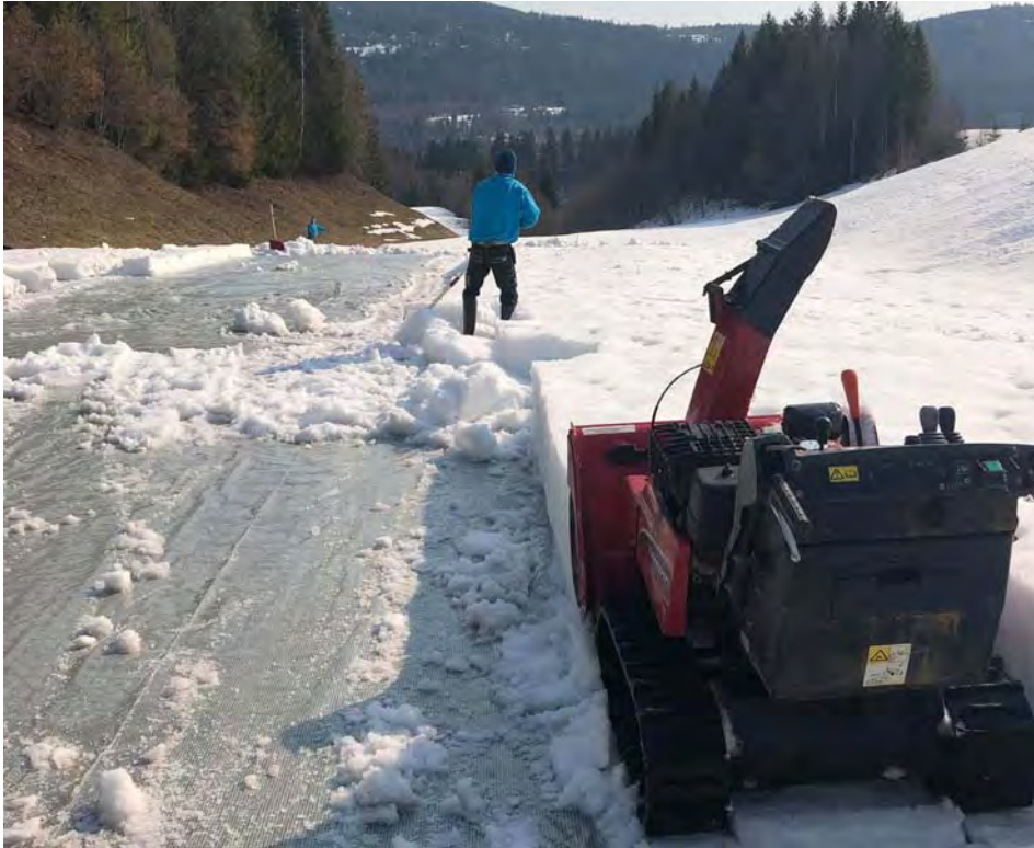
Mynd 5: Brottnám snævar af ógegndræpri ábreiðu kann að vera nauðsynlegt ef eiturgufur gera vart við sig. Ljósmynd: Mads Thers.
