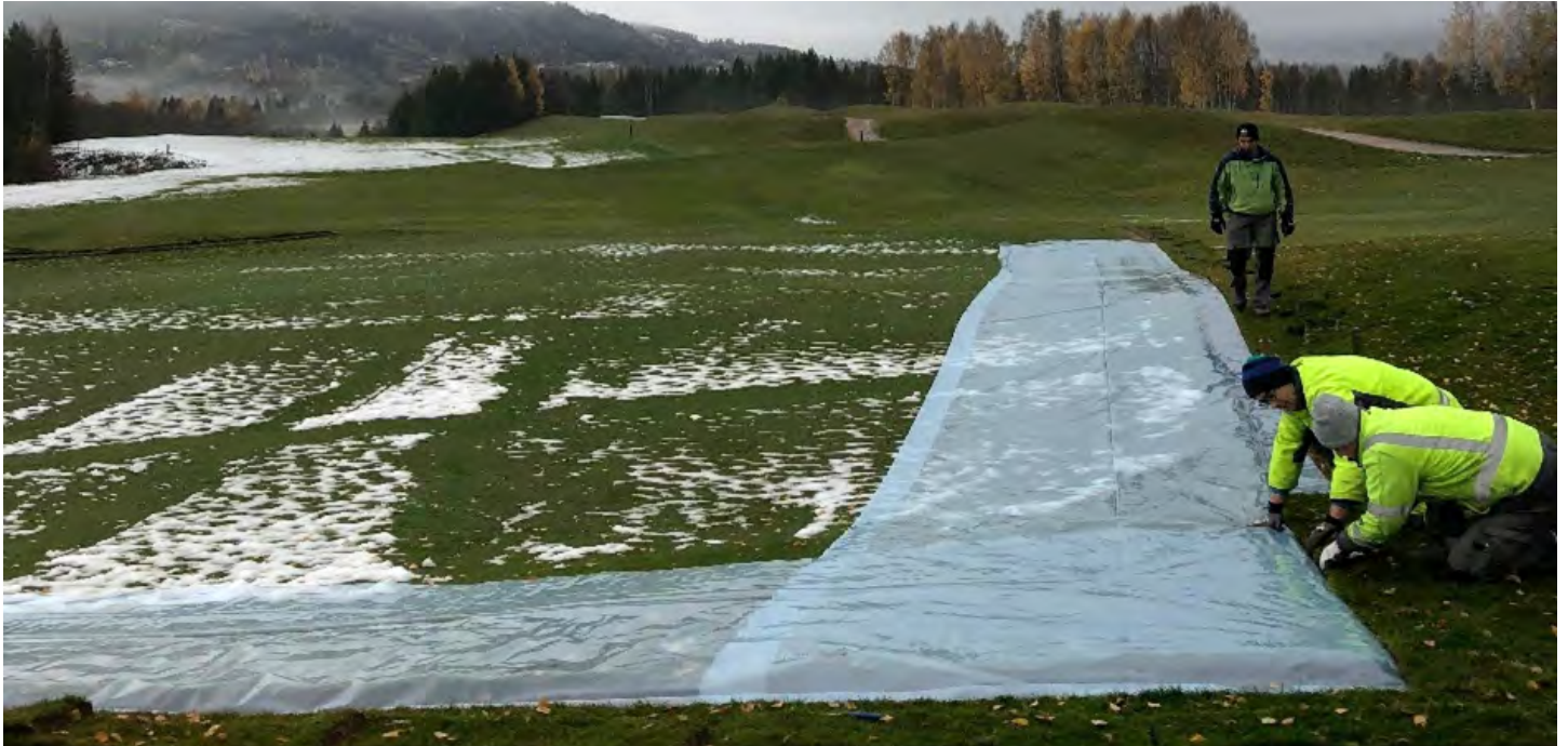
Mynd 4: Mikilvægt er að grafa einskonar plastkraga niður meðfram utanverðum efri flatarbrúnum. Hér eru vor- og vetrardúkarnir báðir festir undir kragann til að varna því að leysingavatn renni inn undir dúkana. Ljósmynd: Mads Thers.
